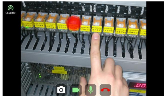
Aus Sicht der Datenbrille: Einsatz eines Laserpointers im Videobild (ausgelöst vom Experten)
